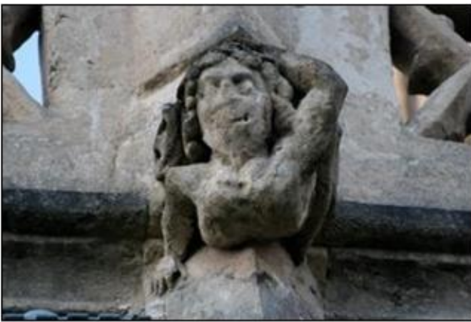
Figura 16. Figura de piedra caliza erosionada en el exterior de una iglesia en Axbridge, Somerset, Inglaterra. Los geomorfólogos pueden proveer conocimiento acerca de las características de los procesos de meteorización y las tasas de estos sobre las construcciones, ayudando por lo tanto en el diseño de estrategias de conservación (Foto: Stephen Tooth).
